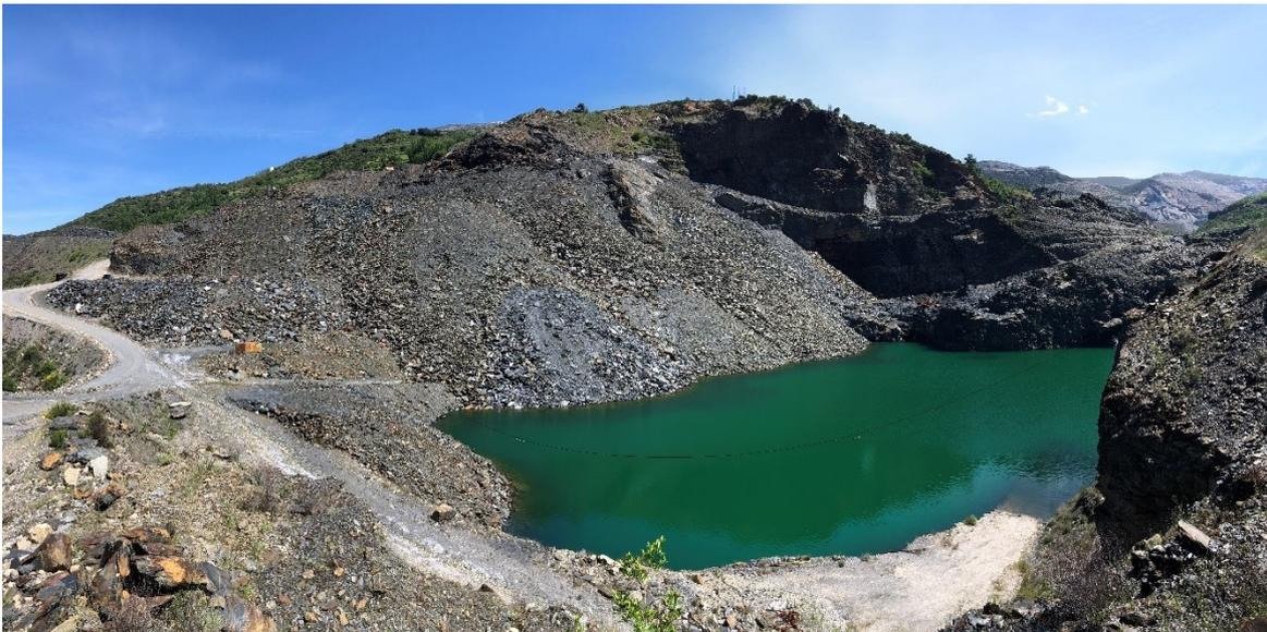
**FOTOGRAFÍA 2-7: VISTA DEL FRENTE DE EXPLOTACION CUBIERTO POR EL DERRUMBE DE MATERIAL ESTERIL**
